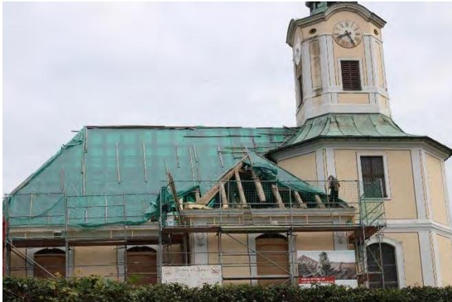
auch die darunter liegende Holzschwelle, die die Verbindung zum Sims bildet. Deshalb musste der komplette Sims auf dem Baugerüst abgestützt werden. Nun wird ein Betonringanker gegossen und mit Eisenstäben mit dem Sims verbunden.
